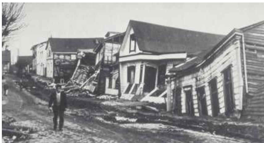
Strada Valdivia (Chile) după cutremurul din 1960
